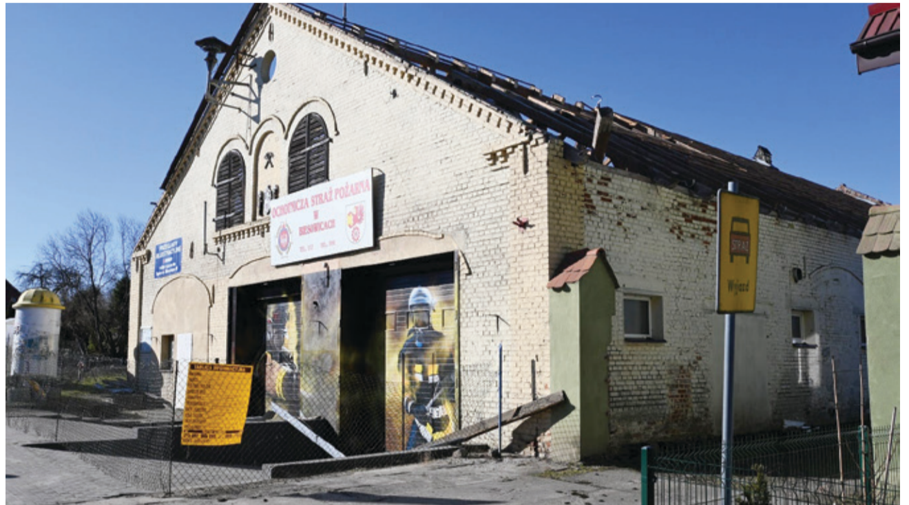
Remiza w Biesowicach właśnie przechodzi gruntowną modernizację.
