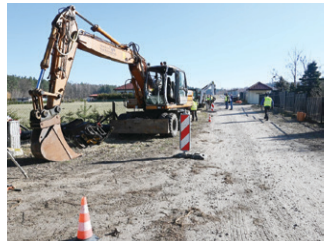
W marcu rozpoczęły się prace budowlane w Łęczkach.
