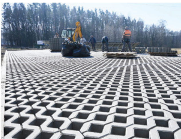
Na początku roku przy ośrodku wykonano nowe miejsca parkingowe.
