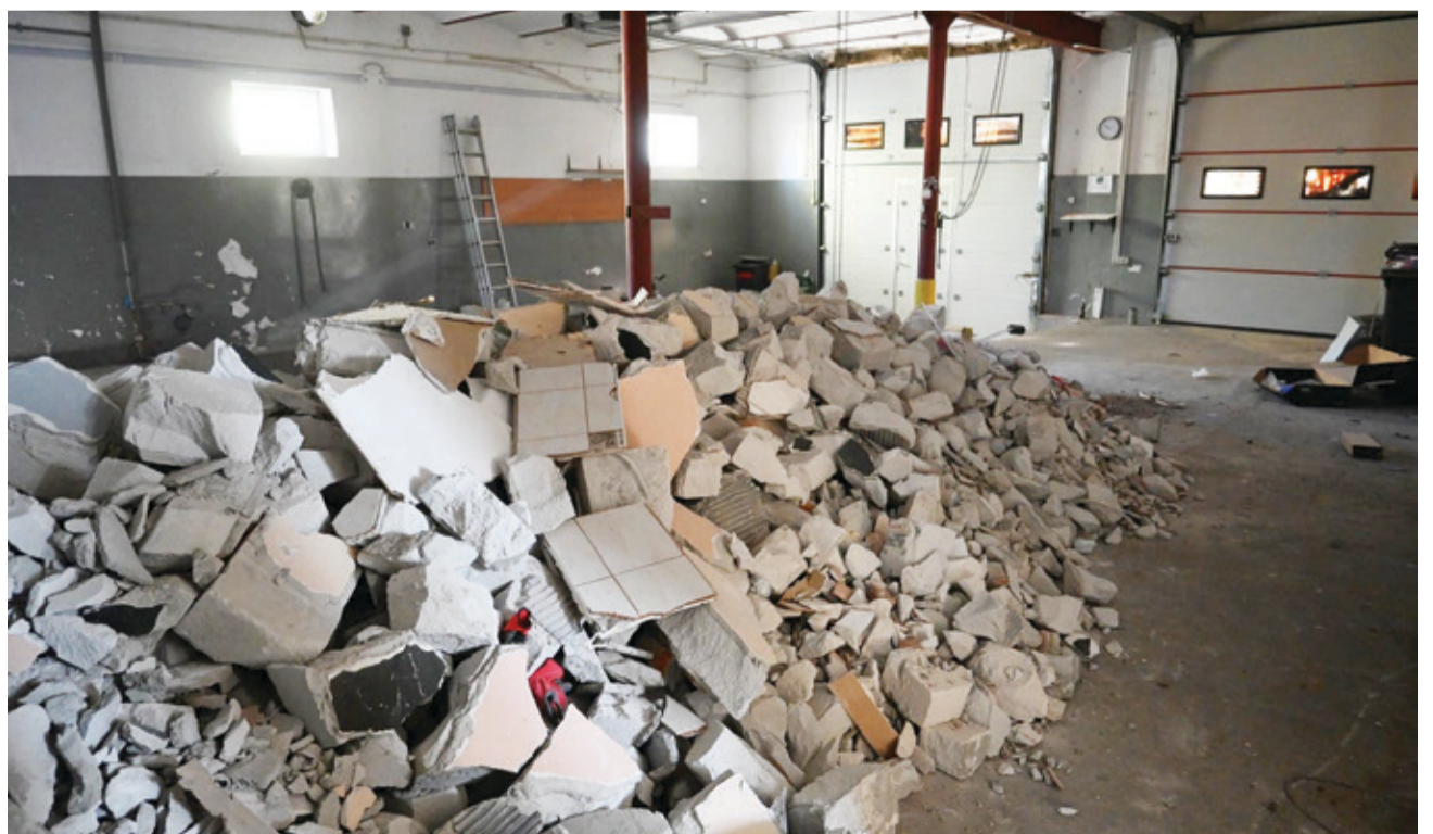
Zadanie obejmuje zarówno prace budowlane, jak i zakup niezbędnego wyposażenia.
