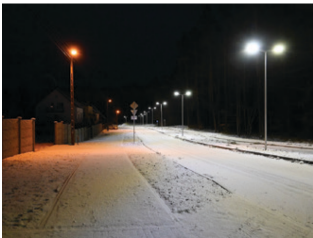
Przy ul. Kochanowskiego wykonano także sieć oświetleniową i zamontowano nowe lampy.
