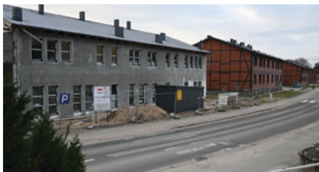
Obiekt jest już na zaawansowanym etapie budowy.
