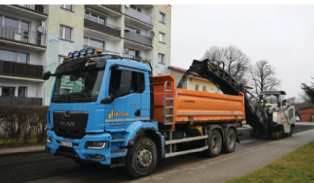
Na początku lutego rozpoczęła się modernizacja ulicy Leśnej w Kępicach.
