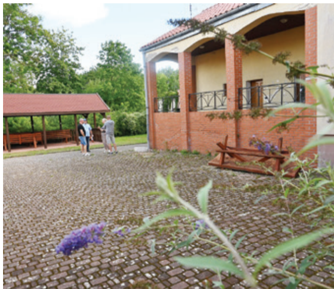
Zakres przeprowadzonych prac jest szeroki. Dodatkowo zostanie zakupione wyposażenie.
