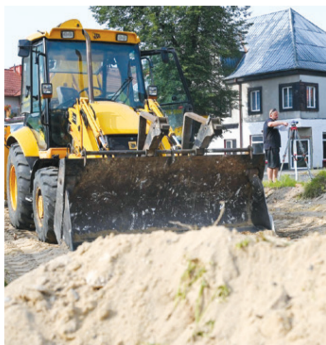
Przy ulicy Sikorskiego trwa budowa targowiska.
