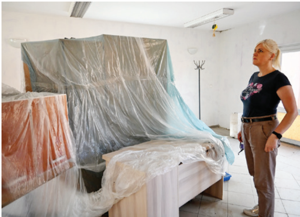
W barwińskiej świetlicy trwają prace remontowe.
