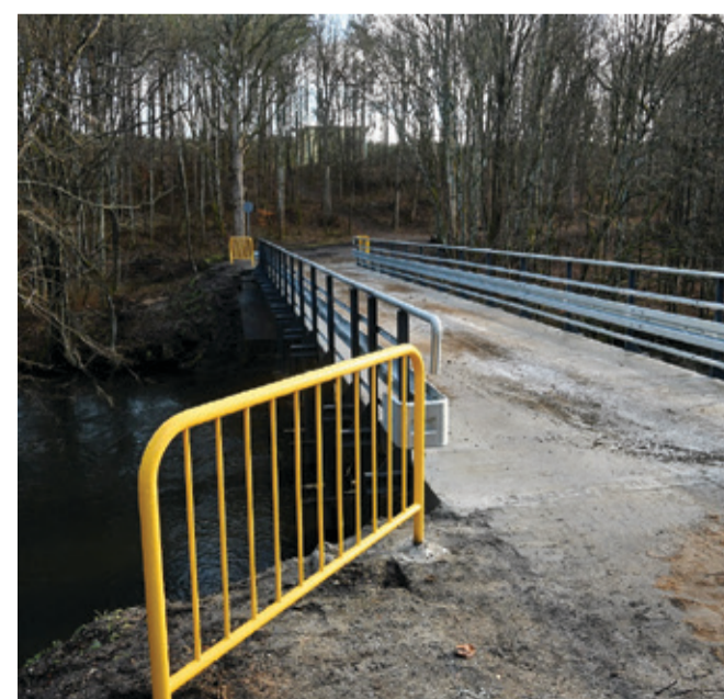
Wyremontowany most w pobliżu ulicy Kępki.
