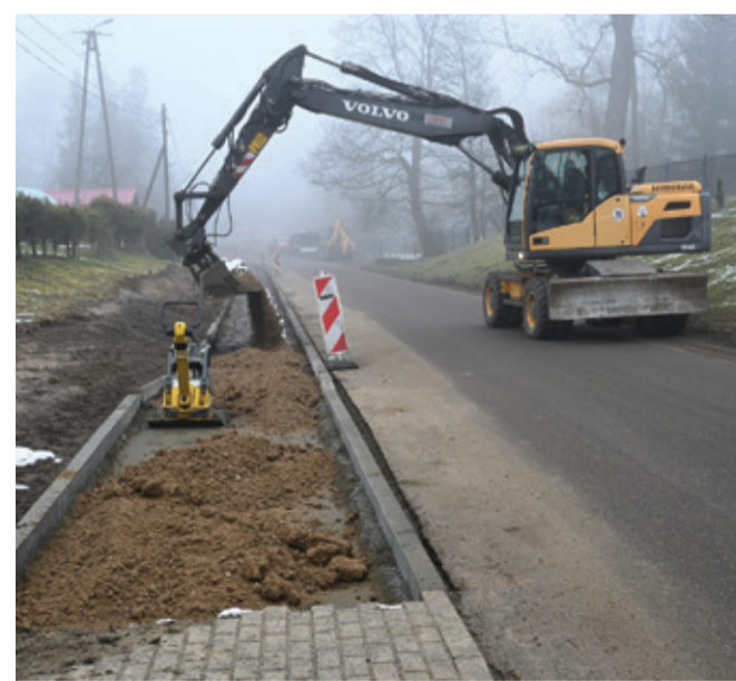
Zarząd Dróg Powiatowych buduje chodnik w Pustowie.
