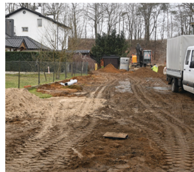
W trakcie prowadzonych prac, prosimy o zachowanie szczególnej ostrożności.
