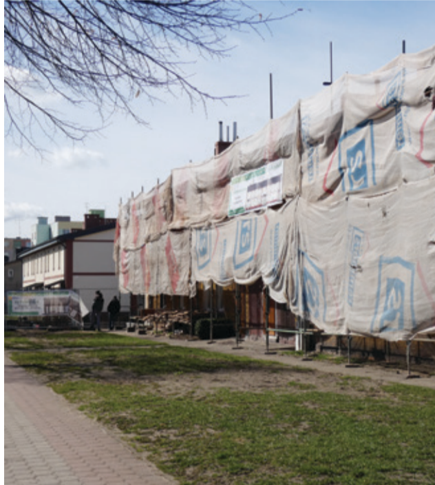
Wykonawca już przystąpił do prac związanych z termomodernizacją budynku wielorodzinnego przy ul. Niepodległości.
