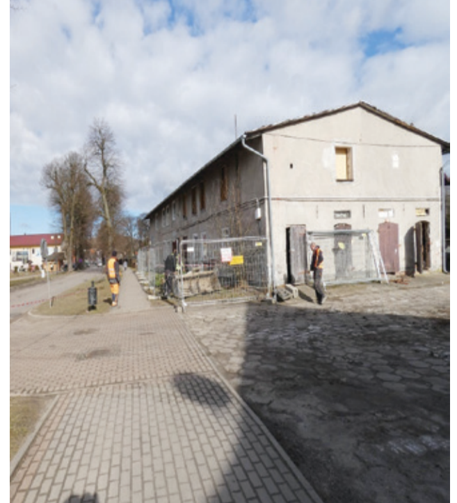
Do niedawna zlokalizowany był tu budynek wielorodzinny. W marcu został rozebrany.
