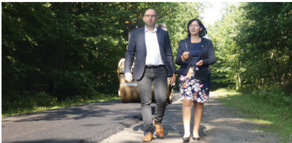
Droga Osowo – Ciecholub właśnie jest modernizowana.
