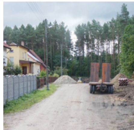
Kochanowskiego w budowie
