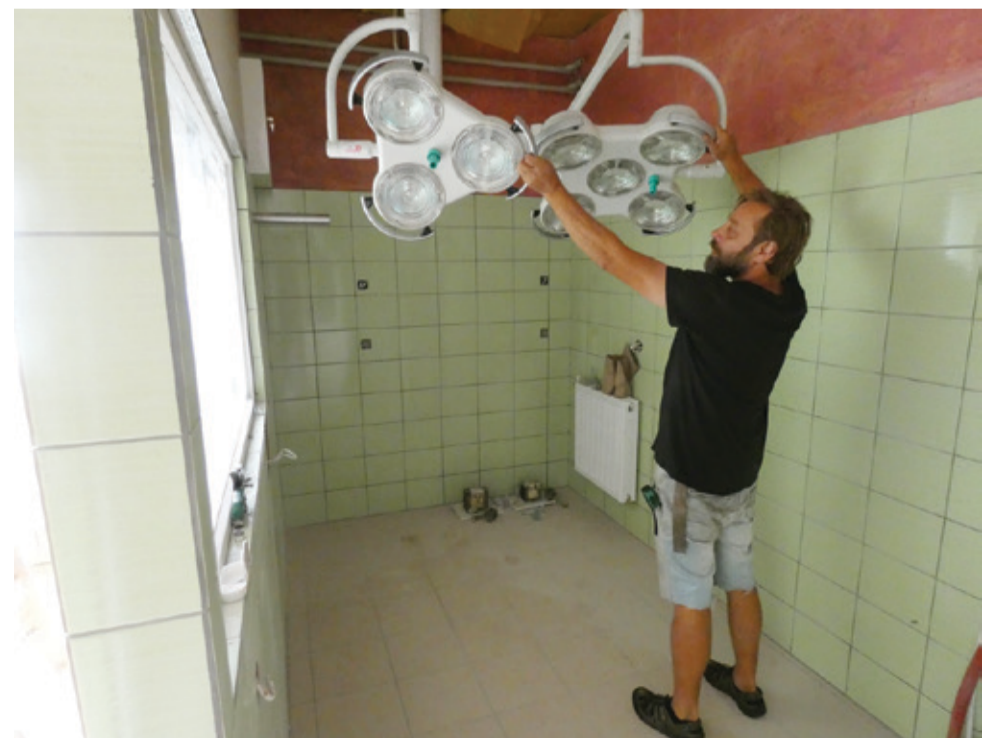
Trwają prace wykończeniowe.
