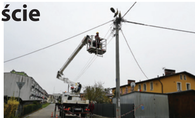
Pracownicy spółki Energa zamontowali specjalną platformę pod gniazdo.
